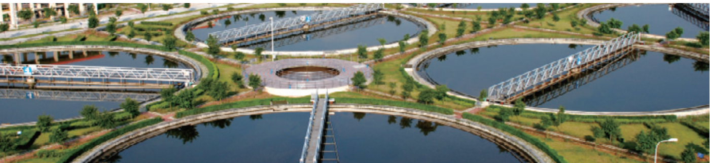
重慶唐家沱污水廠採用環保水力發電。
