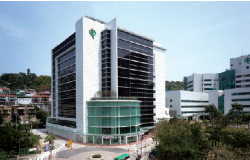
協興建築項目 — 將軍澳醫院擴建工程
