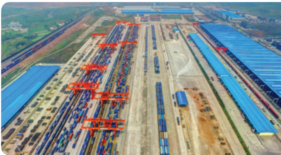
重慶鐵路集裝箱中心站
