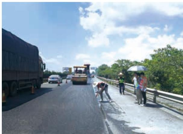
嘗試以瀝青混合舊輪胎物料修路
