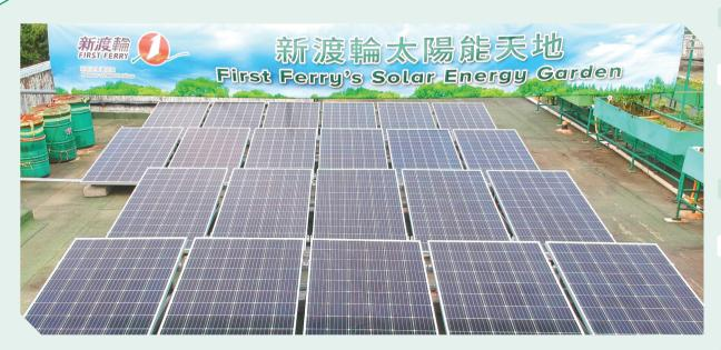
我們在新渡輪辦公室大樓的天台上安裝了太陽能電板,並已連接至電網,其每年預計可產生約 10,500千瓦時的能源,減少5,400公斤的二氧化碳排放。我們亦於旗下渡輪「新忠號」設置了太陽能 電板,以推動船上六個新增的通風系統裝置。
