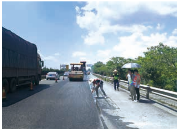
嘗試以瀝青混合舊輪胎物料修路
