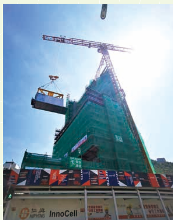
香港科學園創新斗室的建設階段
