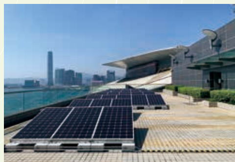
於會展中心天台上安裝了太陽能電板
