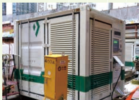
在建築工地使用「淨能櫃」
